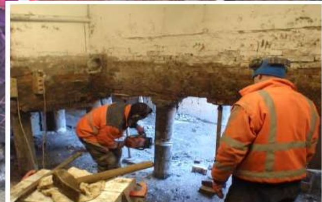
Afbeelding 3, funderingsherstel van een gebouw
